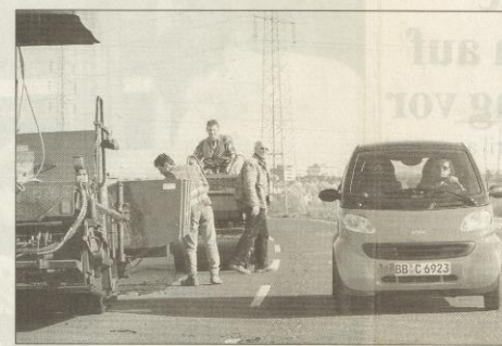
Mit der Frühlingszeit beginnt auch die Zeit der Bauarbeiten innerhalb des 230 000 Kilometer langen Straßennetzes in Deutschland. Gerade diese Bauabschnitte werden oft zu staufälligen Engpässen. Auf der Landstraße müssen jene Kraftfahrer, die das Hindernis auf ihrer Spur haben, bei Gegenverkehr warten. Foto: GL
